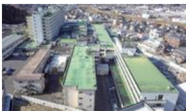
旧病院解体前（平成 31 年1月）
