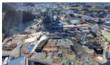
旧病院解体中（令和 2年1月）
